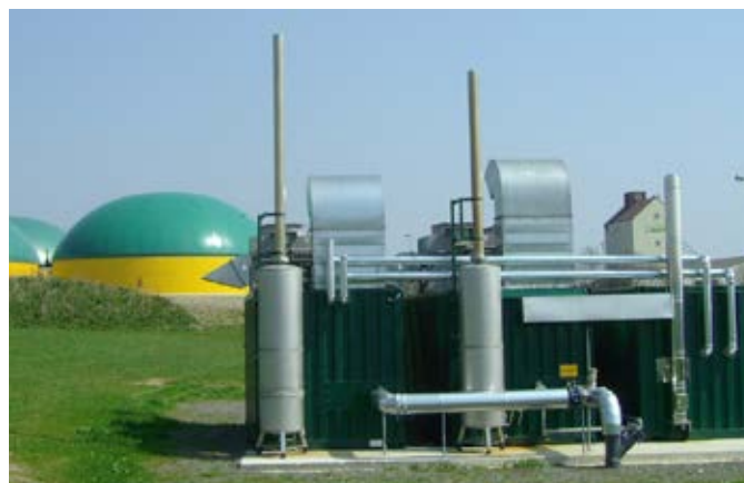
▲ Abbildungen: YADO|KWK Biogas Anlage in Modulbauweise
