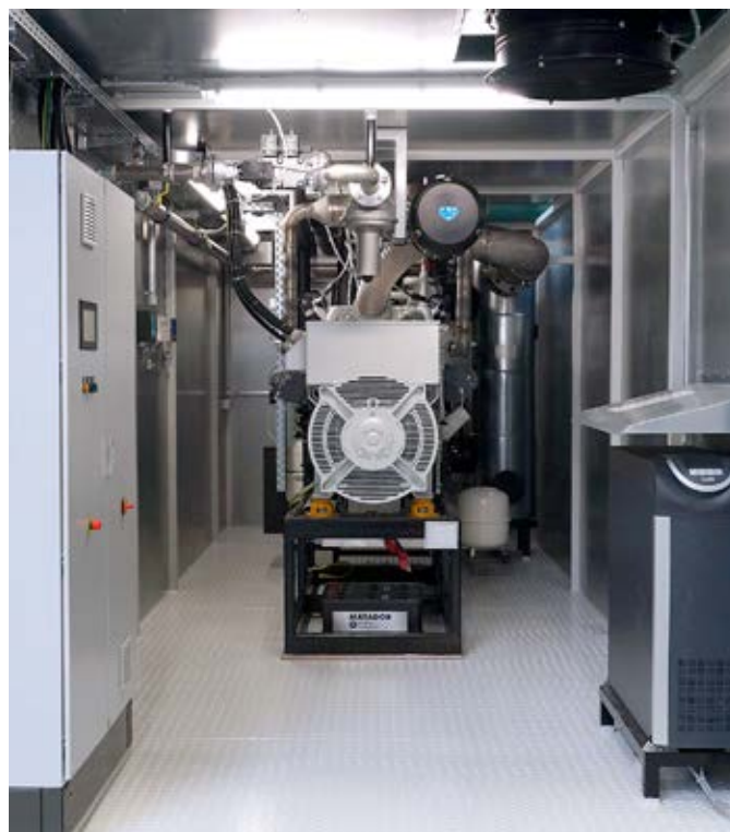
▲ Abbildung YADO|KWK Blockheizkraftwerk im Systemcontainer
