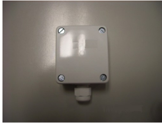
TA1 Außentemperaturfühler
