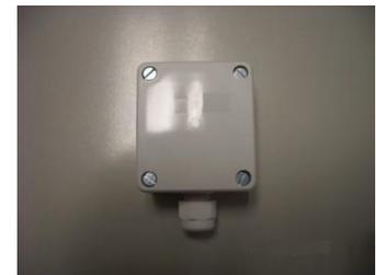
Abbildung 10: Außentemperaturfühler TA1
