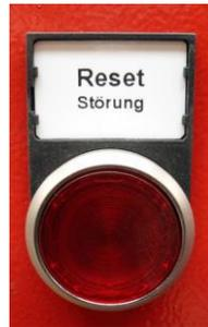
Abbildung 32 - Störungsmeldeleuchte / Reset-Taster
