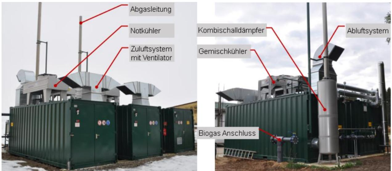
Abbildung 7 - zusätzliche Bauteile einer BHKW-Containeranlage
