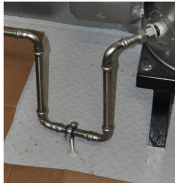
Abbildung 21 - Kondensatablauf mit Wasservorlage (U-Rohr)
