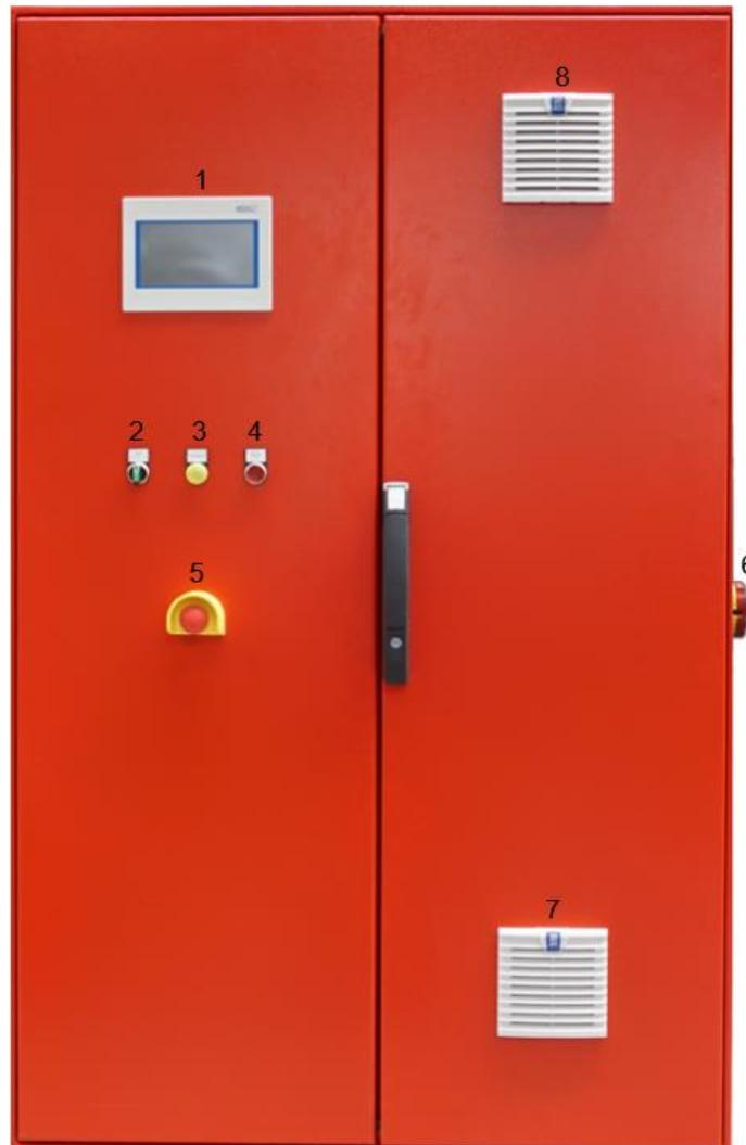
Abbildung 27 - Beispiel der Bauteile in der Modulsteuerung (außer EG-50 BW / EGC (50)
