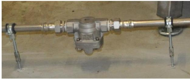
Abbildung 20 - Kondensatablauf mit Kondensatableiter
