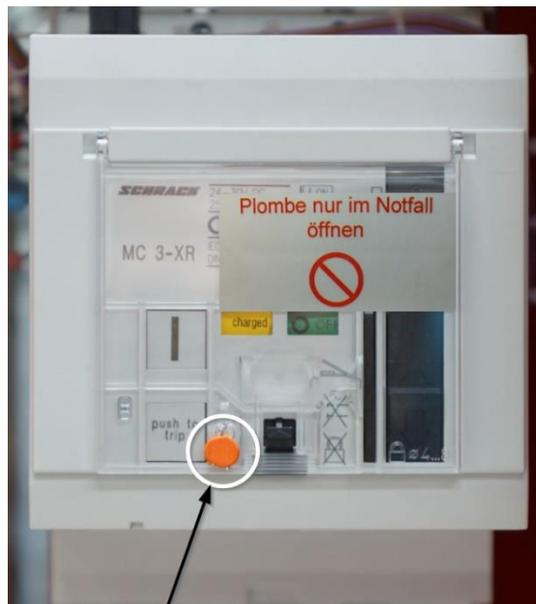
Abbildung 58 - Generator-Leistungsschalter mit Sicherungsverplombung
