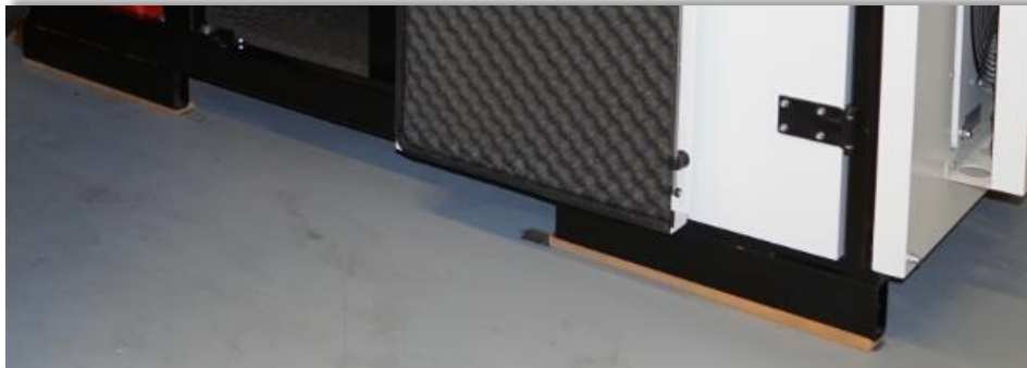
Abbildung 56 - Sylomerstreifen (braun) vollflächig zwischen der Aufstellfläche und den Kastenprofilen
