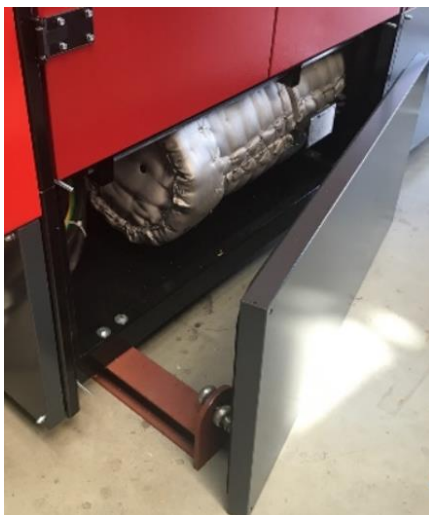
Abbildung 50 - BHKW auf Transporttraversen und Schwerlastrollen (rechts)
