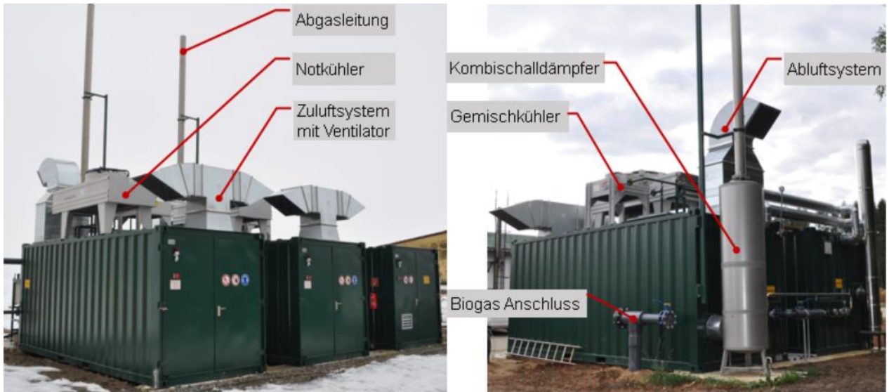
Abbildung 7 - zusätzliche Bauteile einer BHKW-Containeranlage
