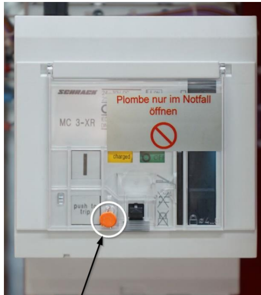
Abbildung 57 - Generator-Leistungsschalter mit Sicherungsverplombung
